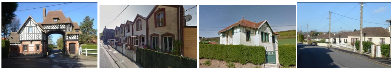
Figures 83, 84, 85 et 86 : Bâti rural / logement ouvrier en brique et enduit / logement ouvrier en ciment armé / Pavillons
