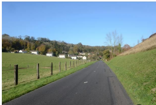
Figure 78 : Entrée depuis la route d'Aubermesnil (RD100)
