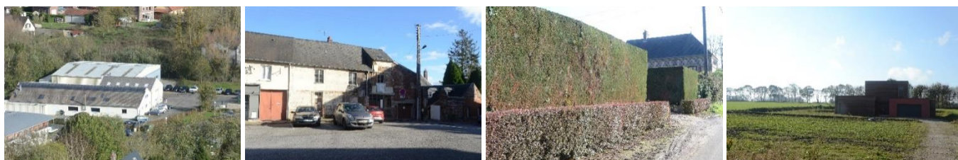
Figures 91, 92, 93 et 94 : Bâtiment de volume très imposant / Défaut d'entretien / Mur végétal / Faiblesse de l'accompagnement paysager
